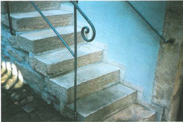
Eingangstreppe mit Blockstufen.
