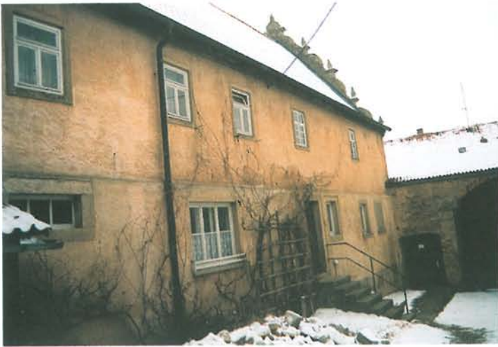
Putz als Fassadenschutz.
