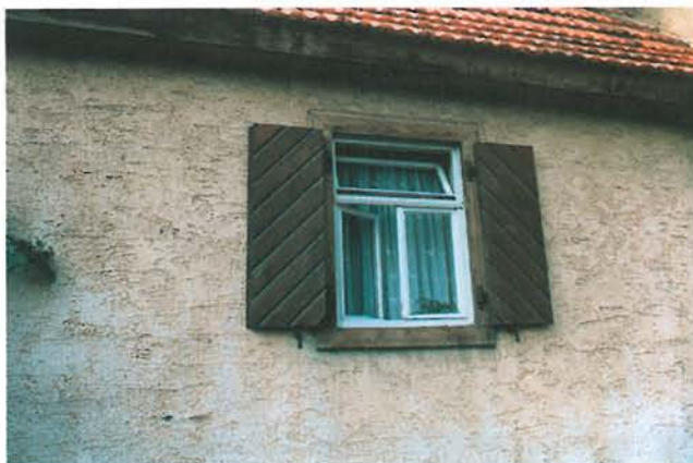
Klappläden aus Holz dienen der Verdunkelung und sind zugleich Gestaltungselement der Fassade.
