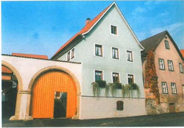
Verputzte Fassade mit drei Fensterachsen und abgesetztem Sockel.
