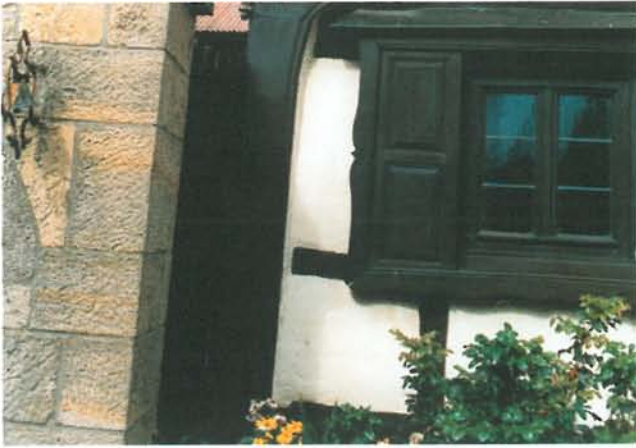
Historische Baumaterialien sollen erhalten werden.
