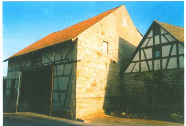
Fachwerk und historisches Sichtmauerwerk sollen freigehalten werden.
